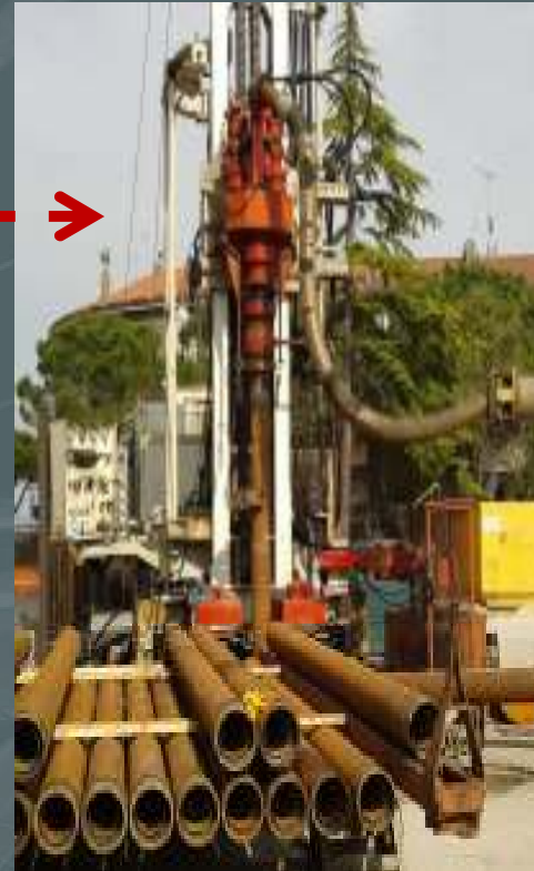
Impianto a circolazione inversa 30-272 m
