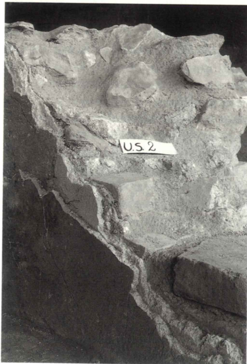
Fig. 3 - Ambiente A, muro nord, testata ovest della porta con laterizi e il rivestimento di intonaco dipinto a finto granito nero. Foto C.T.M. 6738.
