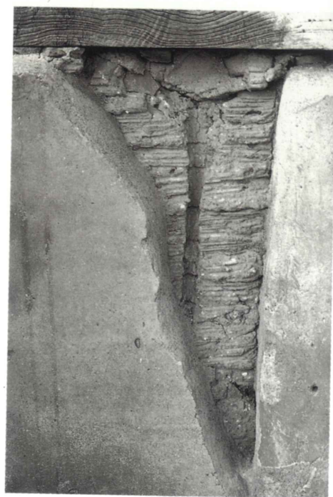
Fig. 13 - Pompei, casa I 13,9: intonaco giallo applicato su argilla e canne disposte in senso orizzontale. Foto de Vos.
